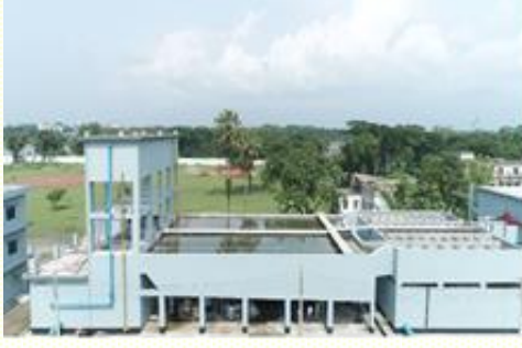
পানি শোধনাগার (Treatment Plant)
