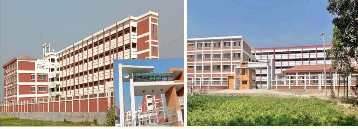
চিত্র: চলমান “১০০ টি উপজেলায় ১টি করে টেকনিক্যাল স্কুল ও কলেজ স্থাপন (২য় সংশোধিত)” প্রকল্পের আওতায় নির্মিত চিত্র-১: আক্কেলপুর টিএসসি ক্যাম্পাস, জয়পুরহাট এবং চিত্র-২: মুজিবনগর টিএসসি ক্যাম্পাস, মেহেরপুর
